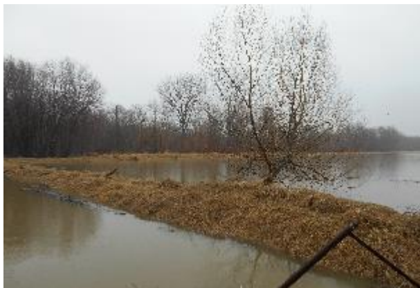
Figure 21: Présence de digue
